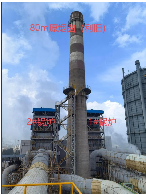
废气排放口 (DA035)
