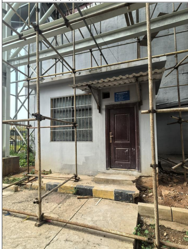
排口在线监测站房 (利旧)
